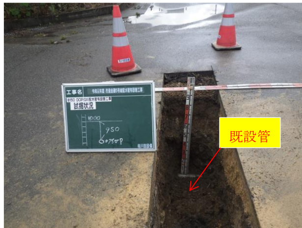
図 7-1 試掘による既設管接続箇所の確認例
