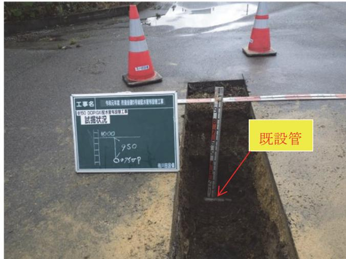
図-5.7 試掘による既設管接続箇所の確認例
