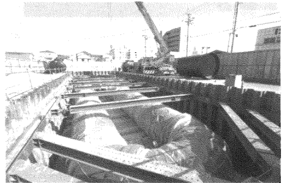
写真9 配管完了状況
