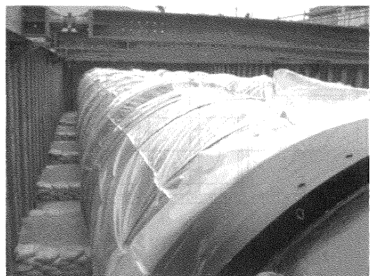
写真3 切梁と管との間隔状況
