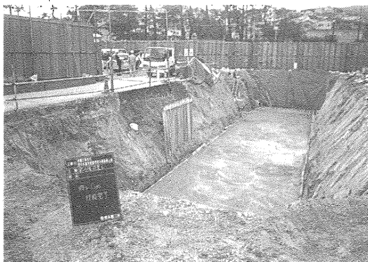
写真2 均しコンクリート打設状況
