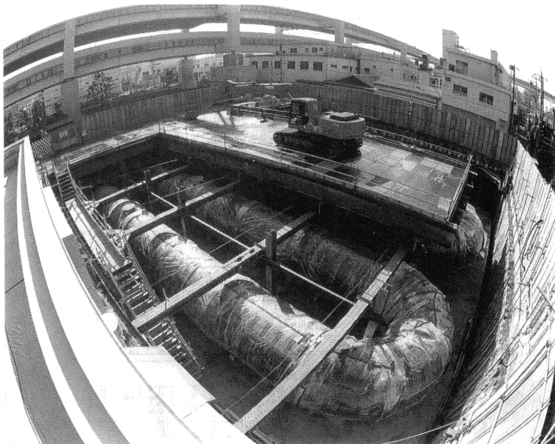
写真1 循環式貯水槽
