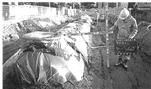
写真6 給水室築造および流入流出管布設後の状況
