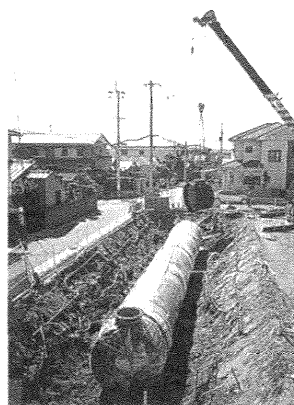
写真4 貯水槽本体布設状況
