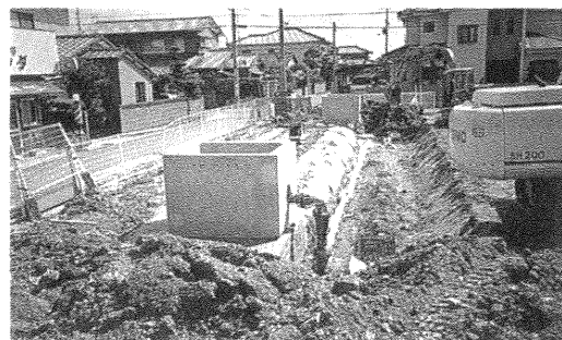
写真6 給水室築造および流入流出管布設後の状況
