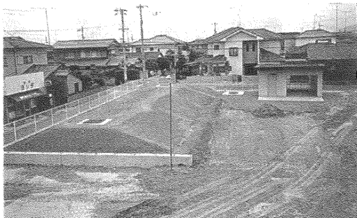
写真7 盛土完成状況
