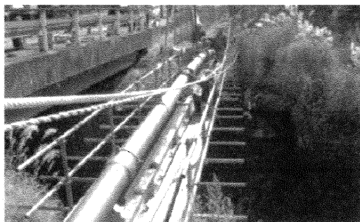
写真8 新設管設置状況
