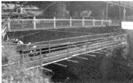
写真3 仮設作業用足場設置
