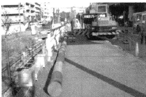
写真4 材料搬入の状況
