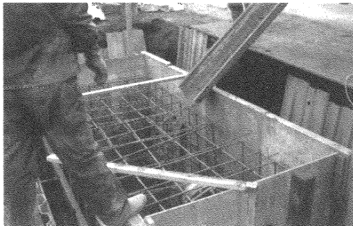
写真6 橋台コンクリート打設状況
