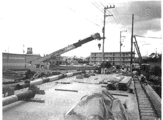
写真4 施工状況（呼び径200mmの場合）（仮設支持台を使用した一括吊り込み方法）
