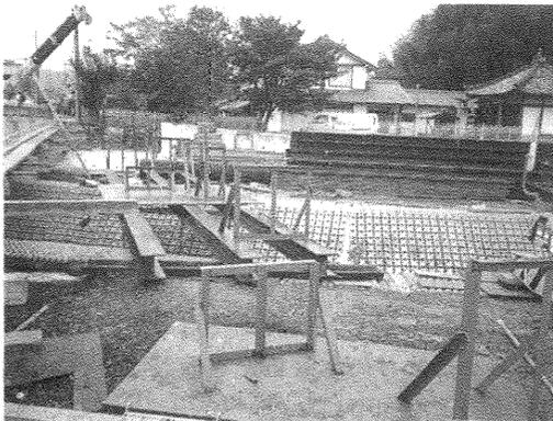
写真3 呼び径200mmの陸組みの状況
