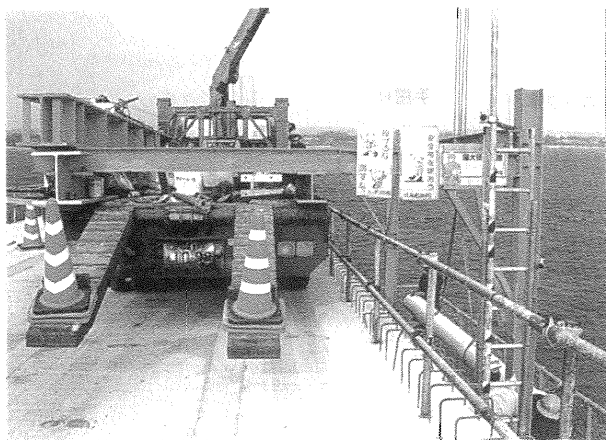
写真2 10トンユニック作業車(踊り場付)
