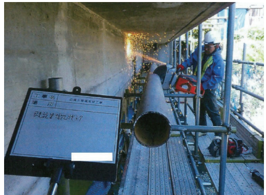
写真4 既設鋼製水管橋の撤去状況
