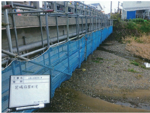
写真3 吊り足場設置状況
