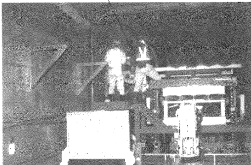
写真2 管受台の取り付け
