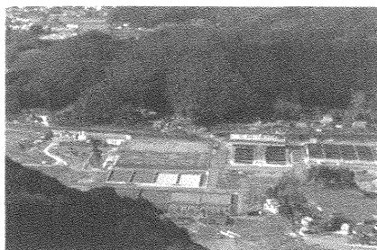
写真1 井手浦浄水場全景
