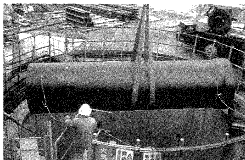
写真4 立坑よりの管吊りおろし状況 (U形 \phi 1500 \times 6000\text{mm} )
