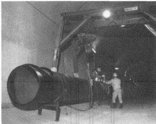
写真-6 管接合状況
