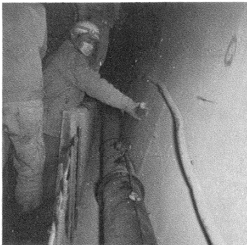
写真-5 鑄鉄管布設状況
