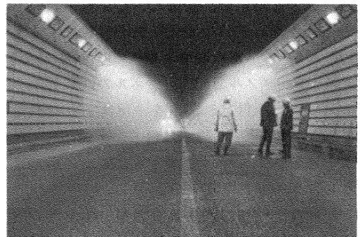
写真四 水噴霧状況
