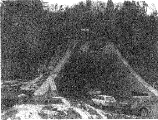
写真一 完成近い東坑口
