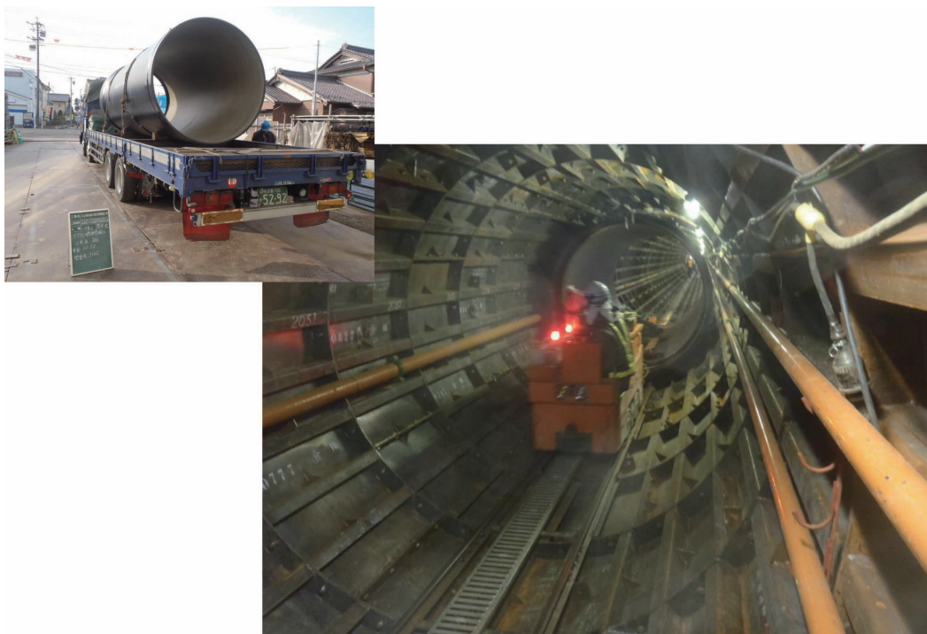
写真2 US形ダクタイル鉄管搬入状況
