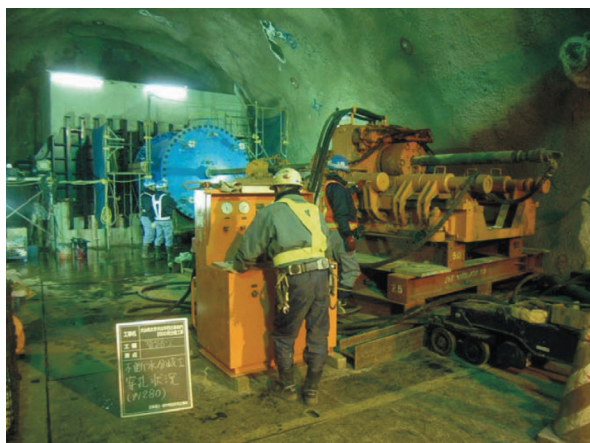
写真3 分岐部施工状況
