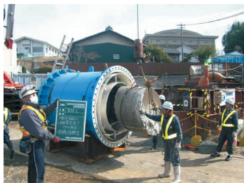
写真4 コンクリート切片引抜状況
