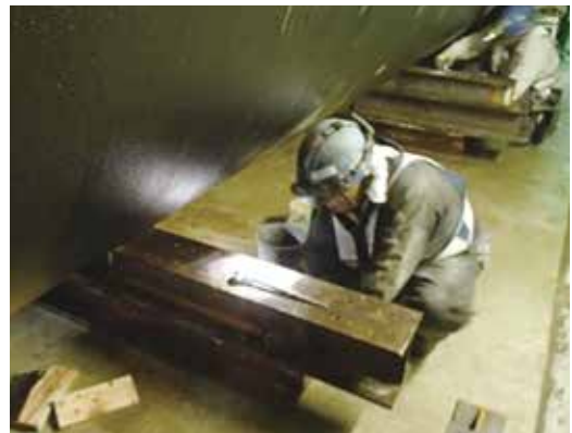
写真7 管受台施工状況
