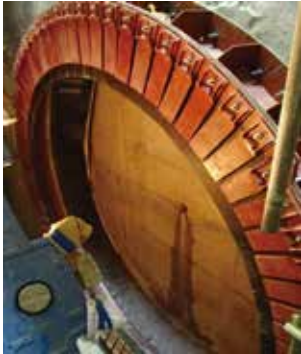
写真4 発進立坑坑口
