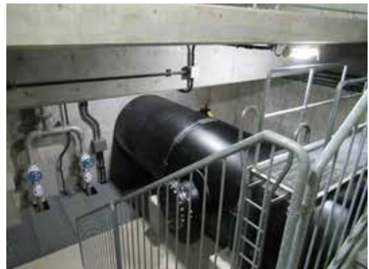
写真9 完成写真(立坑部)
