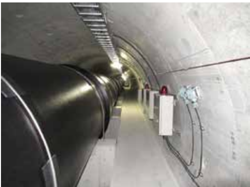
写真8 完成写真(坑内)
