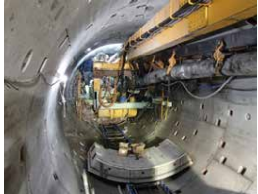
写真5 シールド掘進状況
