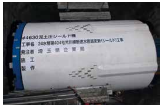
写真3 シールドマシン
