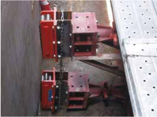
写真1 ガイドローラー設置
