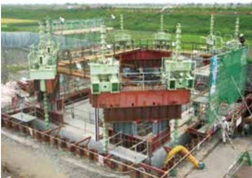
写真2 ケーソン沈設状況
