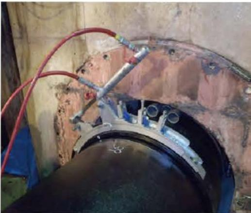
写真6 PN形 接合状況(ロックリング挿入)
