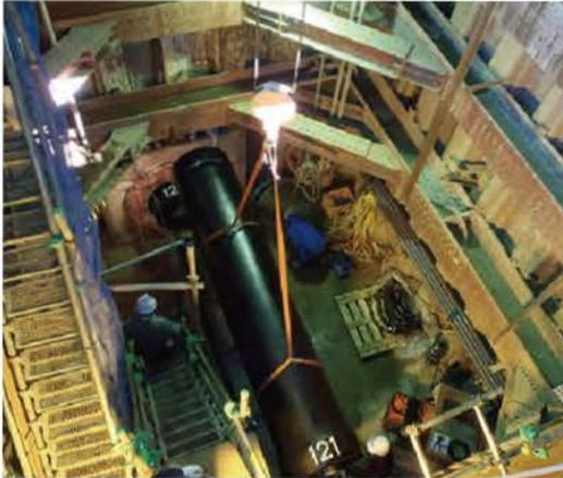
写真5 PN形 管の吊下し状況
