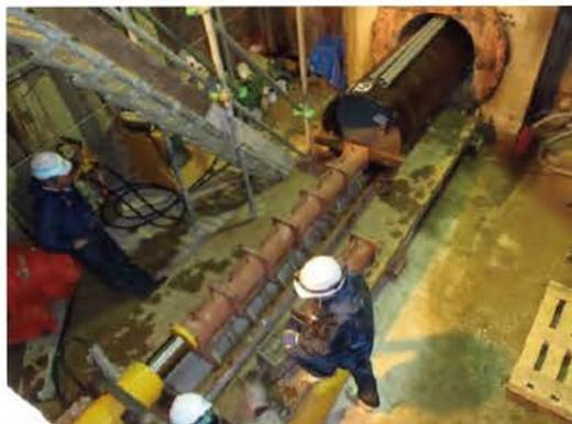
写真11 PN形管挿入状況②
