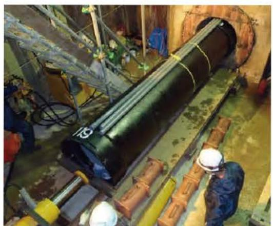
写真10 PN形 管挿入状況①
