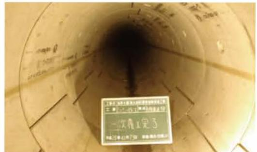
写真4 1次覆工(シールドトンネル)完了
