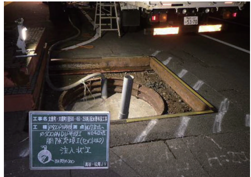
写真11 管理用立坑からの中詰め注入状況
