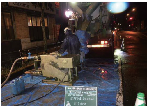
写真10 中詰め注入状況
