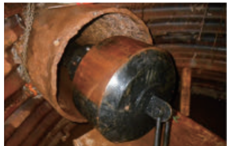
写真5 模擬管調査状況
