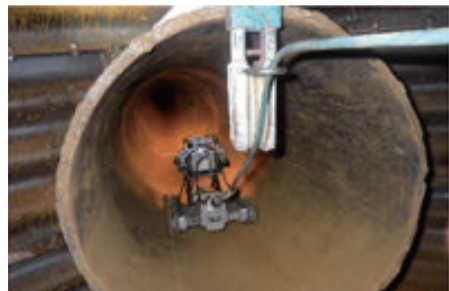
写真6 カメラ調査状況
