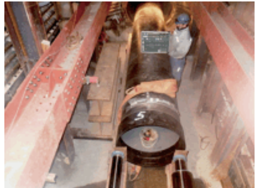
写真2 管挿入状況
