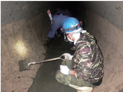
写真1 既設管内インバート工の状況
