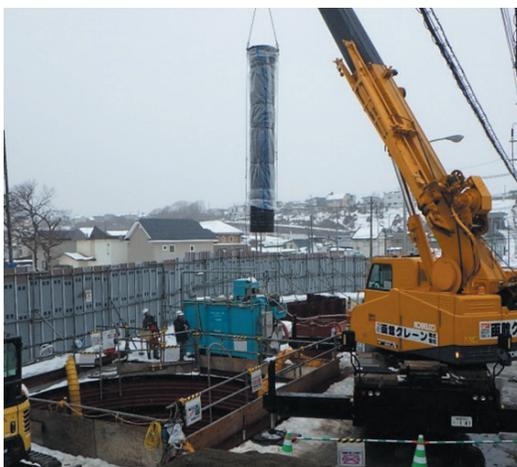
写真6 立坑内NS形管吊り降ろし
