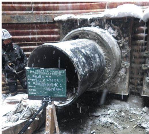
写真5 エアモルタル充填完了
