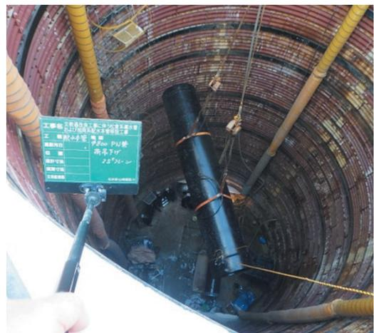
写真3 発進立坑内PN形管吊り降ろし
