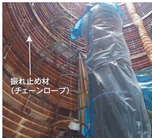
写真7 立坑内NS形配管(振れ止め材)
