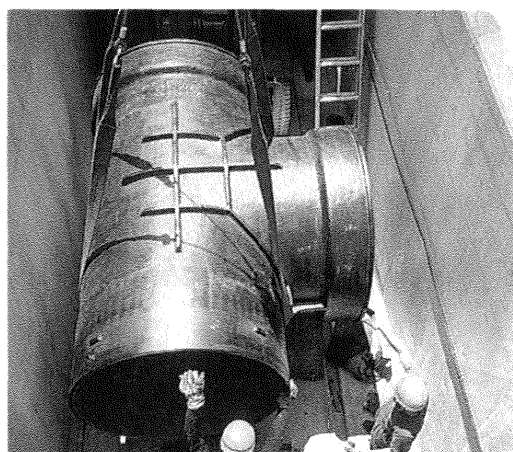
写真2 ダクタイトイル鉄管の吊り降ろし状況
