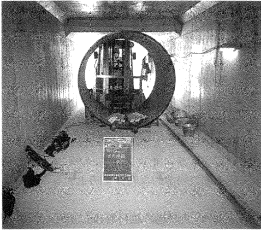
写真3 直管の運搬状況
