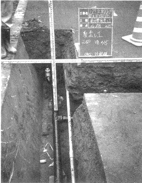
写真10 給水管取り出し工
