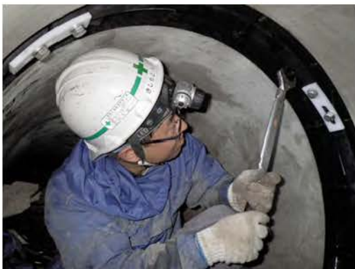
写真4 継手接合状況
