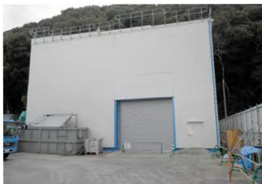
写真6 発進立坑の状況
