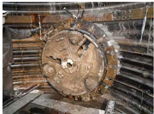
写真5 立坑に到達した掘進機
