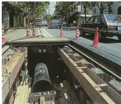
神戸市水道局 PⅡ形(さや管PC 呼び径1350)呼び径1200 1993(平成5)年度 No.56
