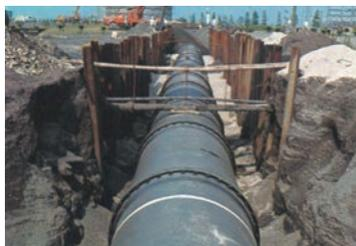
53 K形 呼び径2100 / 四国電力 / 1968 (昭和43) 年 / 西条火力発電所 (冷却用海水取水管)
