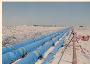
58 T形 呼び径1400×2条・1200×2条 / カタール / 2016年 / 海水淡水化プラント～ドーハへの送水管
