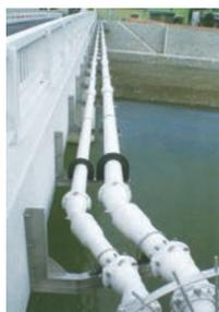
●図表5-9-4-3 大阪府大阪市 S II形呼び径400×2条污水圧送管
