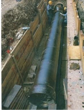
大阪市水道局 TN形（さや管CIP 呼び径1000）呼び径900 1981（昭和56）年度 No.32
