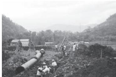
18 遠心力鑄造法による初のダクタイル鉄管。
