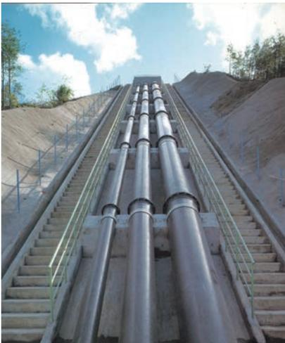
48 K形 呼び径300・500・700 / 島根県企業局石見地域開発事務所 / 1984(昭和59)年 / 江津浄水場～江津調整池間(傾斜角43%)
