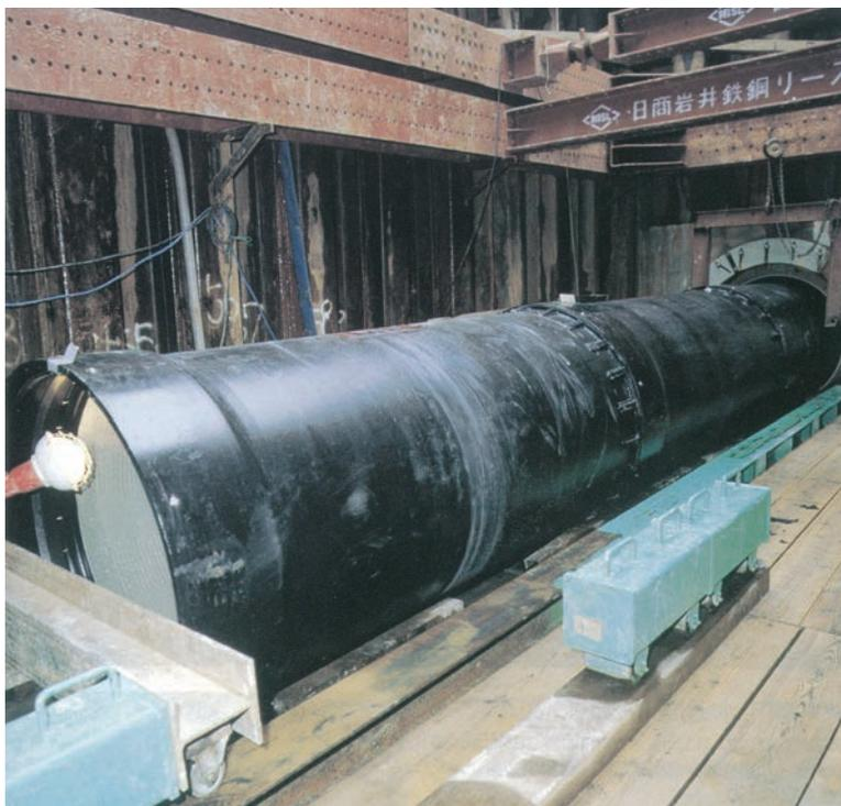
38 PⅡ形 呼び径1100／福岡市水道局／1997(平成9)年／カーブ推進さや管内配管
