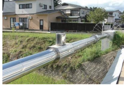
寒冷地において管内の水が凍結する恐れがある場合は、管の外周に適当な防凍工を施す。防凍工としては、一般に管の外周に硬質ウレタンフォームなどの保温材を巻き、その周囲を外装材で保護する工法が多く採用されている。
