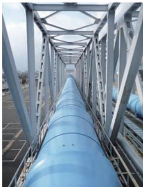
52 S形 呼び径2000 / 東北電力 / 2014 (平成26) 年 / 新潟火力発電所 (冷却用海水取水管)
