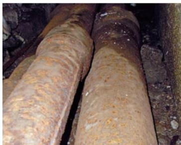
噴水塔で使用されている鑄鉄管。
