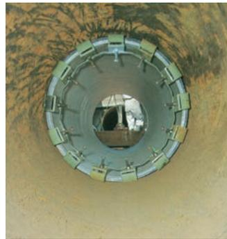
名古屋市上下水道局 P II形（さや管CIP 呼び径500）呼び径400 1984（昭和59）年度 No.39
