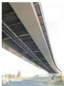
管の支持は、橋梁の主桁、あるいは補桁などに鋼材などで適当な形の支持金具や吊り金具などを取り付けて行う。橋梁の形状に沿って配管するために曲管を添架するなど、水圧による不平均力が作用する管の場合には、その力を保持できる支持金具を使用する必要がある。また、橋梁添架配管の耐震性を高めるため、支持金具の形状・寸法や橋梁取付部のアンカーボルトなどの設計に当たっては、管重や水重に加えて震度法による地震荷重も考慮することが望ましい。
