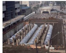
「クボタダクタイル鉄管貯水槽〈耐震用・緊急用〉」より
