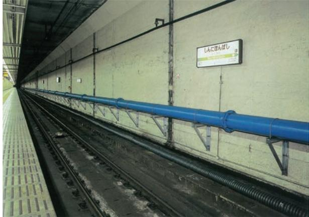
56 K形 呼び径350／JR東日本／2002(平成14)年／総武トンネル内の湧水送水管
