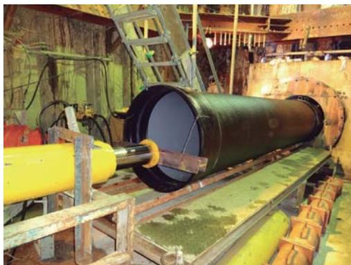
39 PN形 呼び径800 キャスタバンド付き／高知市上下水道局／2012(平成24)年／長距離曲線シールド内配管
