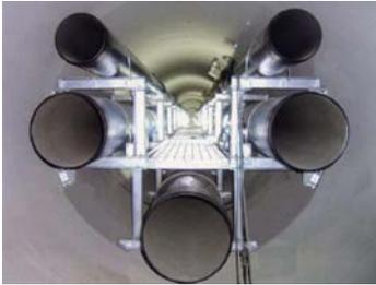
54 NS形 呼び径400・600・700／日本下水道事業団(堺市上下水道局)／2008(平成20)年／下水処理水を工業用水として送水
