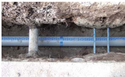
明示テープが貼り付けられた水道管路
