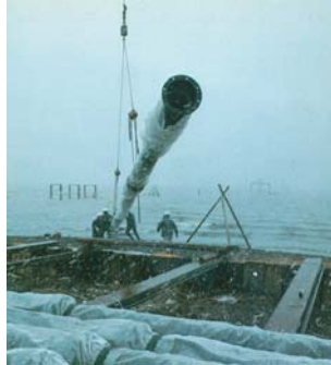
SⅡ形 呼び径250 『ダクタイル鉄管』第28号 (日本ダクタイル鉄管協会)より
