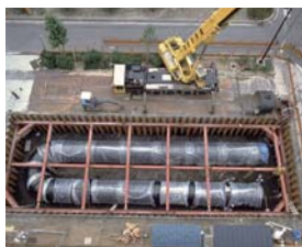
●図表5-8-2-2 耐震貯水槽の配管形状
