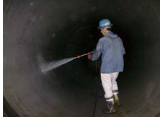
●図表5-8-6-2 高圧洗浄による清掃
