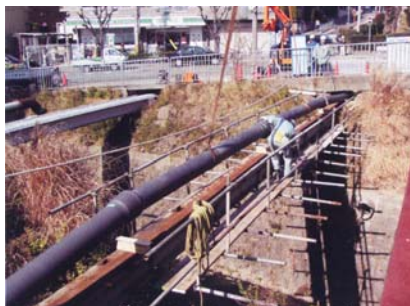
●図表5-9-3-1 大阪府豊中市FT形(タイプII)呼び径250×18.9m
