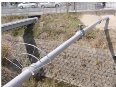
●図表5-9-3-1 大阪府豊中市FT形(タイプII)呼び径250×18.9m
