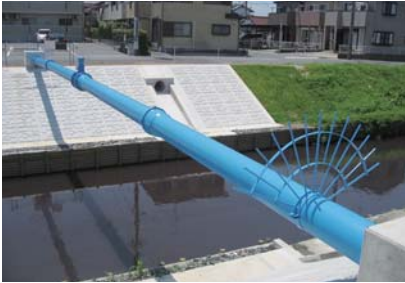
●図表5-9-3-2 静岡県浜松市 FT形(タイプII) 呼び径350×22.23m
