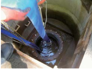
●図表5-8-6-1 槽内排水：水中ポンプ2台
