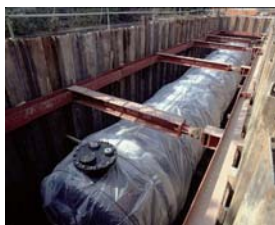
●図表5-8-2-2 耐震貯水槽の配管形状
