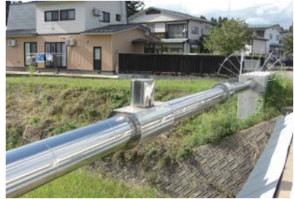
●図表5-9-3-3 秋田県横手市 FT形(タイプII 外装保温付き) 呼び径250×17.8m
