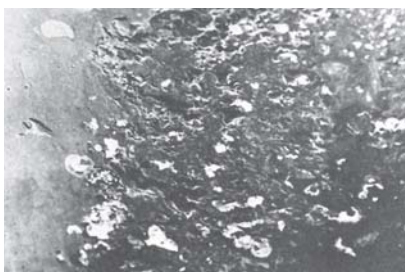
コールタールエナメルライニング
