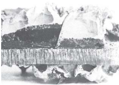
コールタールエナメルライニング
