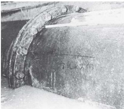
瀬戸内海地方の臨海地帯において、海水面以下に埋設されている呼び径1350ダクタイル鉄管の4年後の外面状況を調査した結果、塗料は全面に顕在であり、発錆はほとんどなく良好な状態であった。
