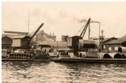
1935 (昭和10) 年ごろの栗本鐵工所千島工場 (現在は閉鎖)。工場敷地内の護岸から港湾船 (はしけ) に積み出された鑄鉄管は、貨物船へと積み替えられ国内外に出荷された。
