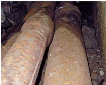
噴水塔で使用されている鑄鉄管。
