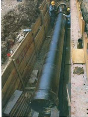
大阪市水道局 TN形(さや管CIP 呼び径1000)呼び径900 1981(昭和56)年度 No.32
