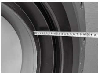
図27 挿し口挿入量の測定
