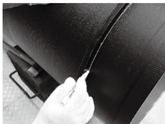
図31 ロックリングをガイドとして白線を引く場合
