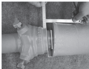
図64 曲げ角度確認方法
