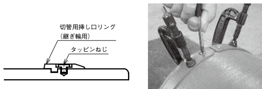
図93 タッピンねじの締め付け
