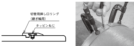
図93 タッピンねじの締め付け
