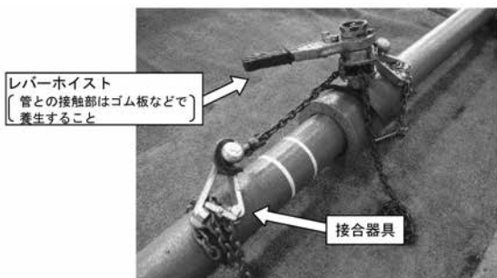
図19 NS形用の器具を用いた接合例2
