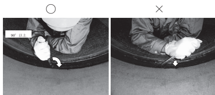
図19 締め付けトルクの確認
