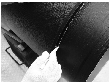
図 30 ロックリングをガイドとして白線を引く場合
