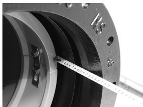
図 40 挿し口挿入量の測定
