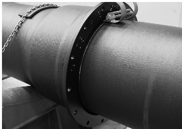
図 32 挿し口の挿入状況
