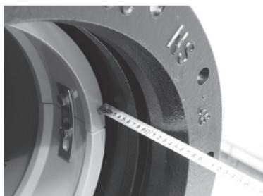
図 41 挿し口挿入量の測定
