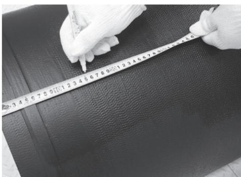
図 28 挿し口側への挿入量の明示
