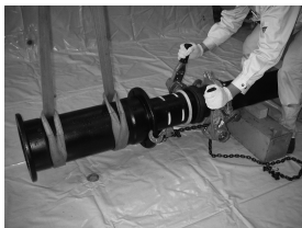
図48 継ぎ輪の先行管への引き込み
