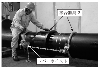
図16 レバーホイストを用いた接合例2(呼び径75～450)
