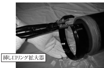
図61 切管用挿しロリングのセット
