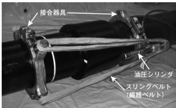
図17 油圧機器を用いた接合例(呼び径300~450)
