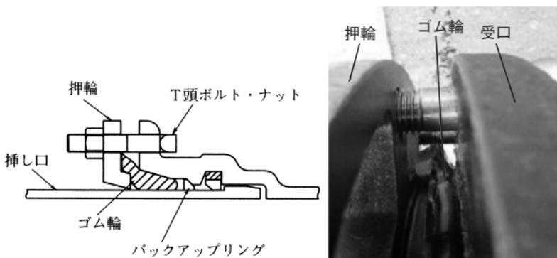
図40 ゴム輪の乗り上げ(接合不良)
