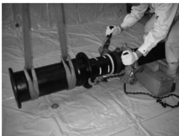
図48 継ぎ輪の先行管への引き込み
