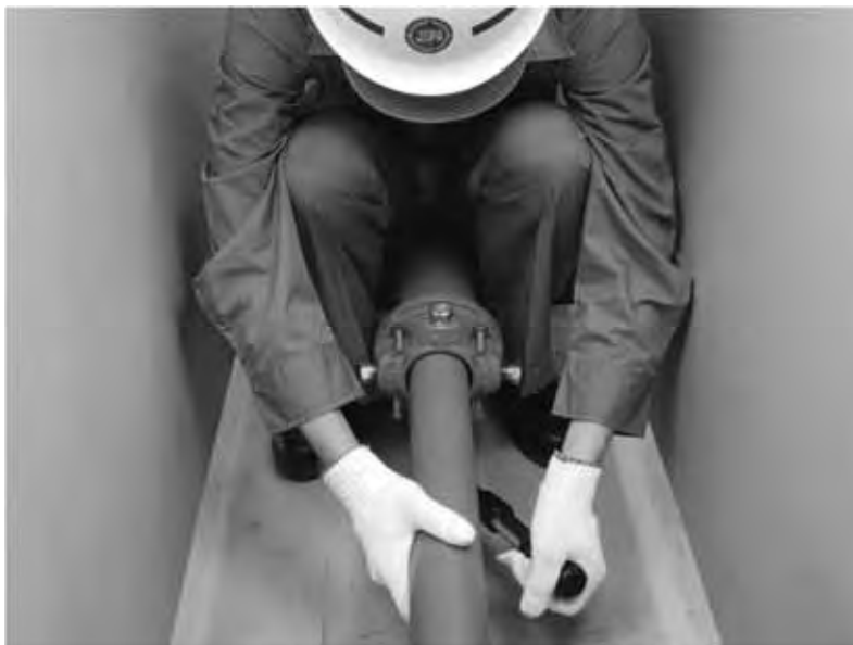
写真2 抜け止め押輪 施工性試験状況
