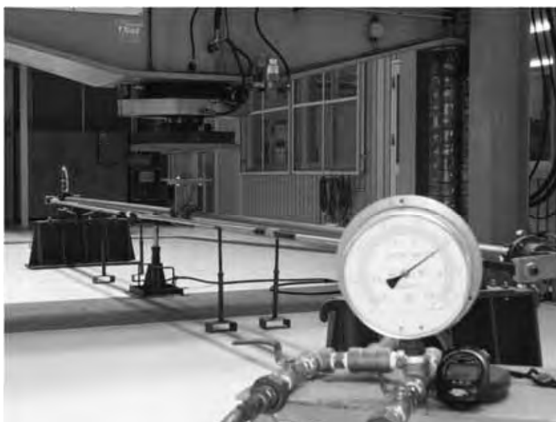
写真5 真直水密性試験状況 (異形管)
