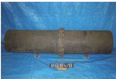
図20 53年間使用された管の外観状況
