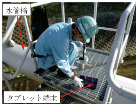
写真6 デジタルカメラ調査状況(水管橋での調査)
