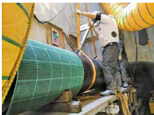
写真2 管の仮置き状況
