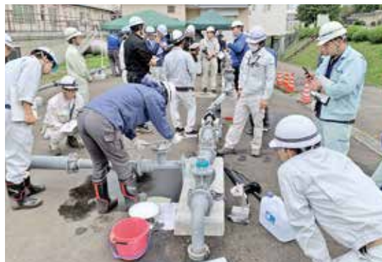
空気弁等維持管理実技研修の状況
