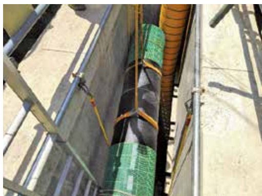
写真1 管吊り下し状況
