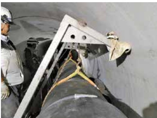
写真 10 布設場所での管吊り上げ状況
