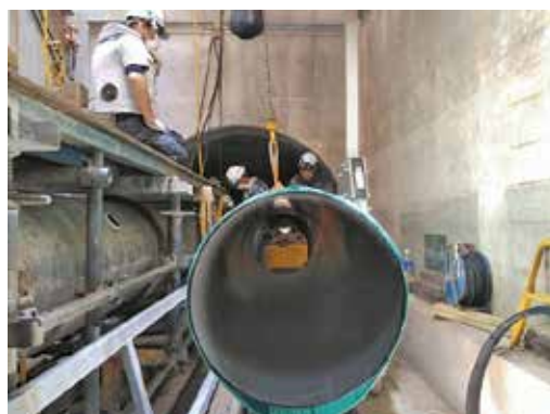
写真4 管の横移動および吊り下し状況
