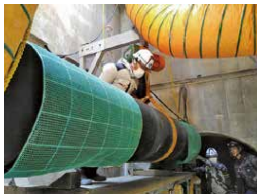
写真3 管の立坑内門型クレーンでの 吊り上げ状況
