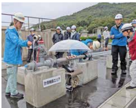
水質改善のための排水研修（流量と管内水の挙動確認）
