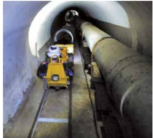
写真8 管運搬状況
