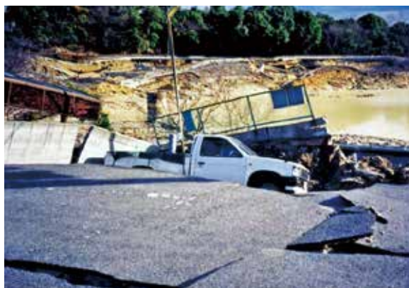
震災発生当時の西宮市内（上：ニテコ池、下：ニテコ池周辺の道路）の様子
