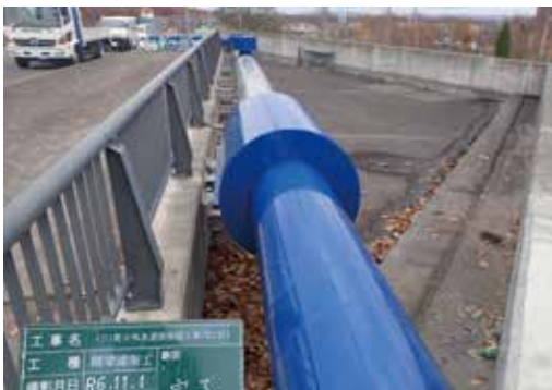
写真4 JR横断個所の添架配管
