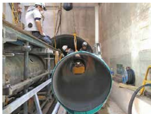
写真4 管の横移動および吊り下し状況
