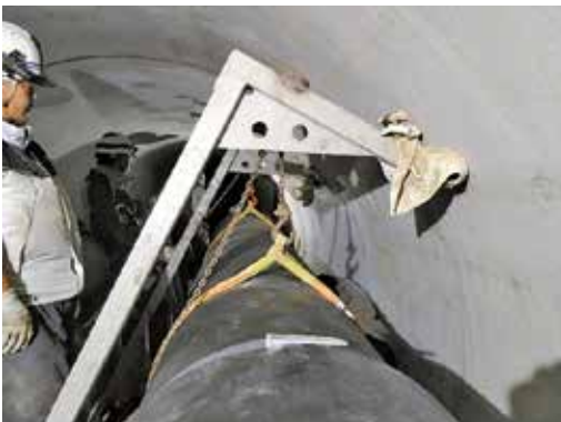
写真 10 布設場所での管吊り上げ状況
