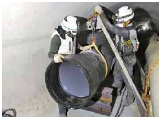
写真 11 布設場所での管の吊り下し状況
