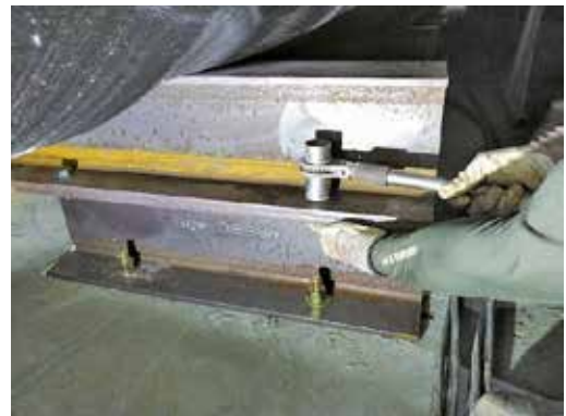
写真9 管受台ボルト締付け状況
