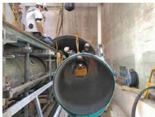
写真4 管の横移動および吊り下し状況
