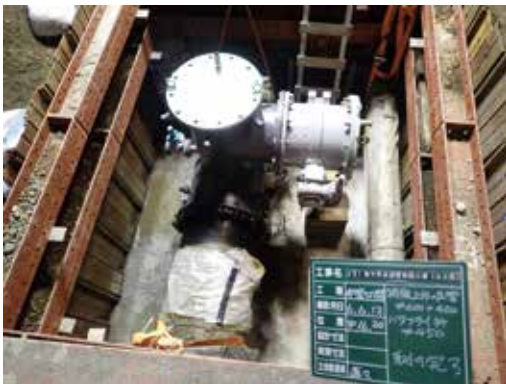
写真3 不断水分岐工
