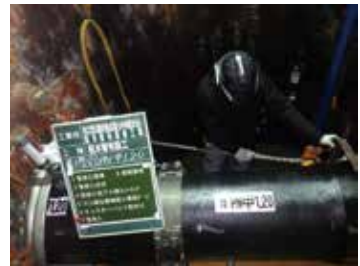
写真6 PN形管挿入状況
