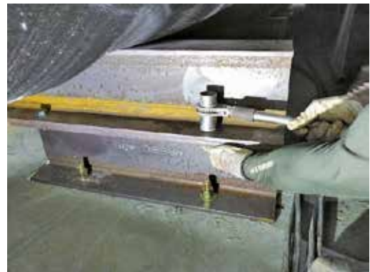
写真9 管受台ボルト締付け状況
