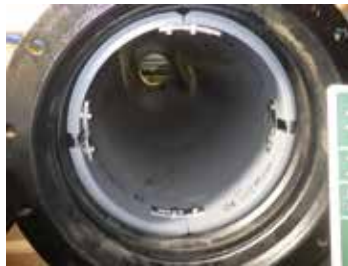
写真5 ライナ設置状況
