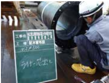
写真4 ライナ心出し作業状況
