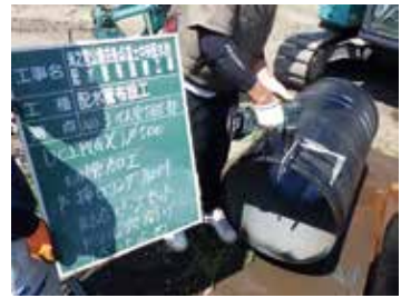
写真3 挿しロリング加工状況
