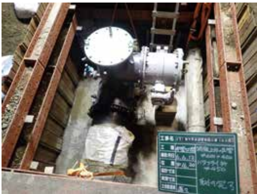
写真3 不断水分岐工
