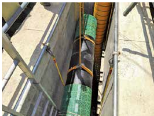
写真1 管吊り下し状況
