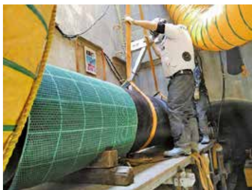
写真2 管の仮置き状況
