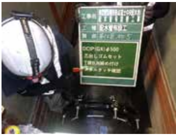
写真1 メタルタッチの確認
