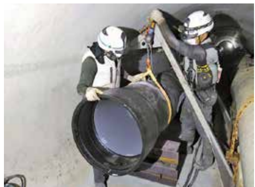
写真 11 布設場所での管の吊り下し状況
