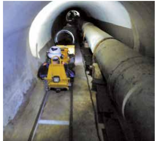
写真8 管運搬状況
