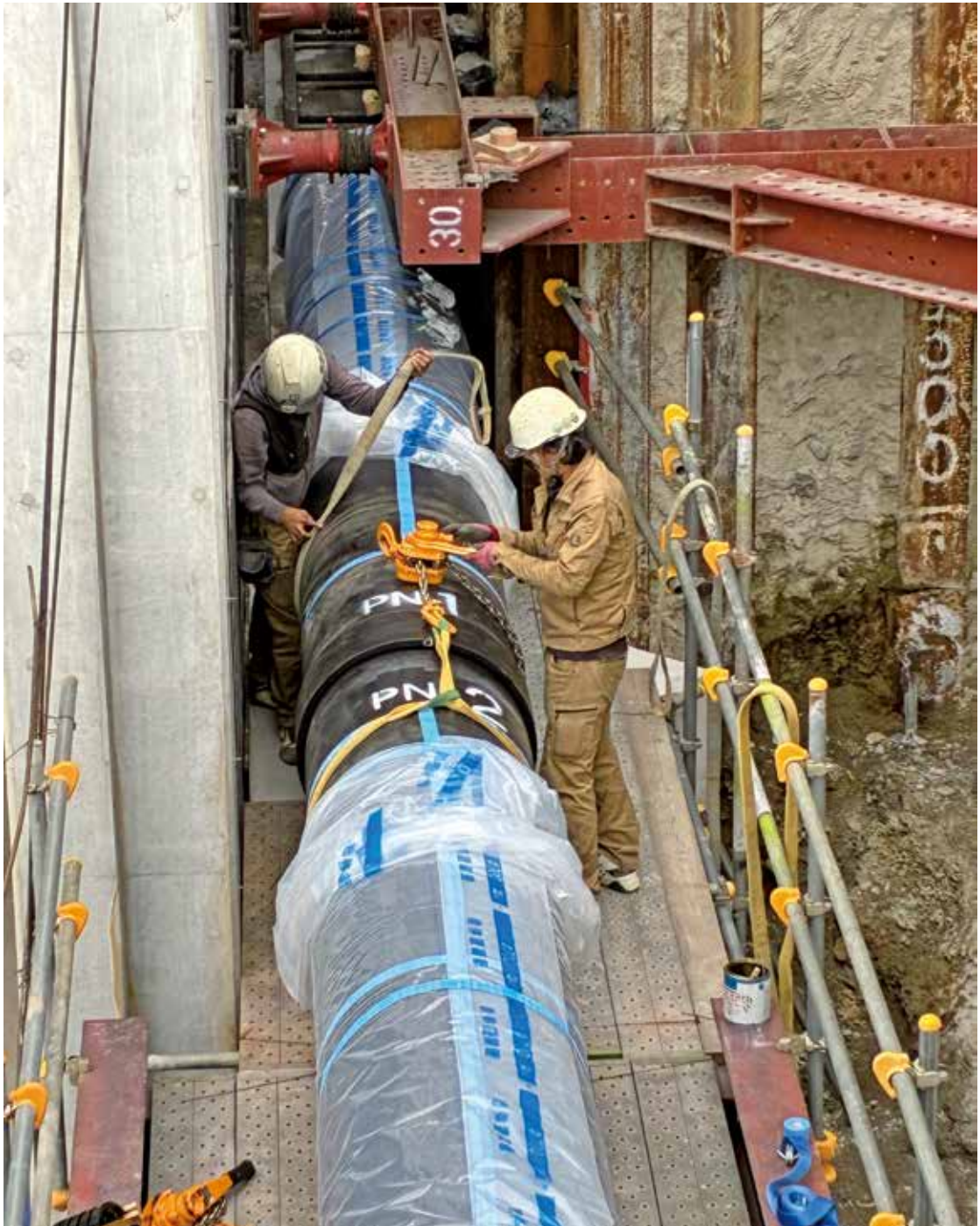
岡山市水道局 PN形 呼び径700
