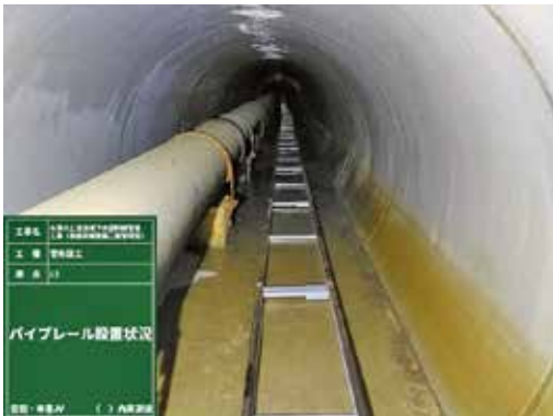
写真5 レール設置状況
