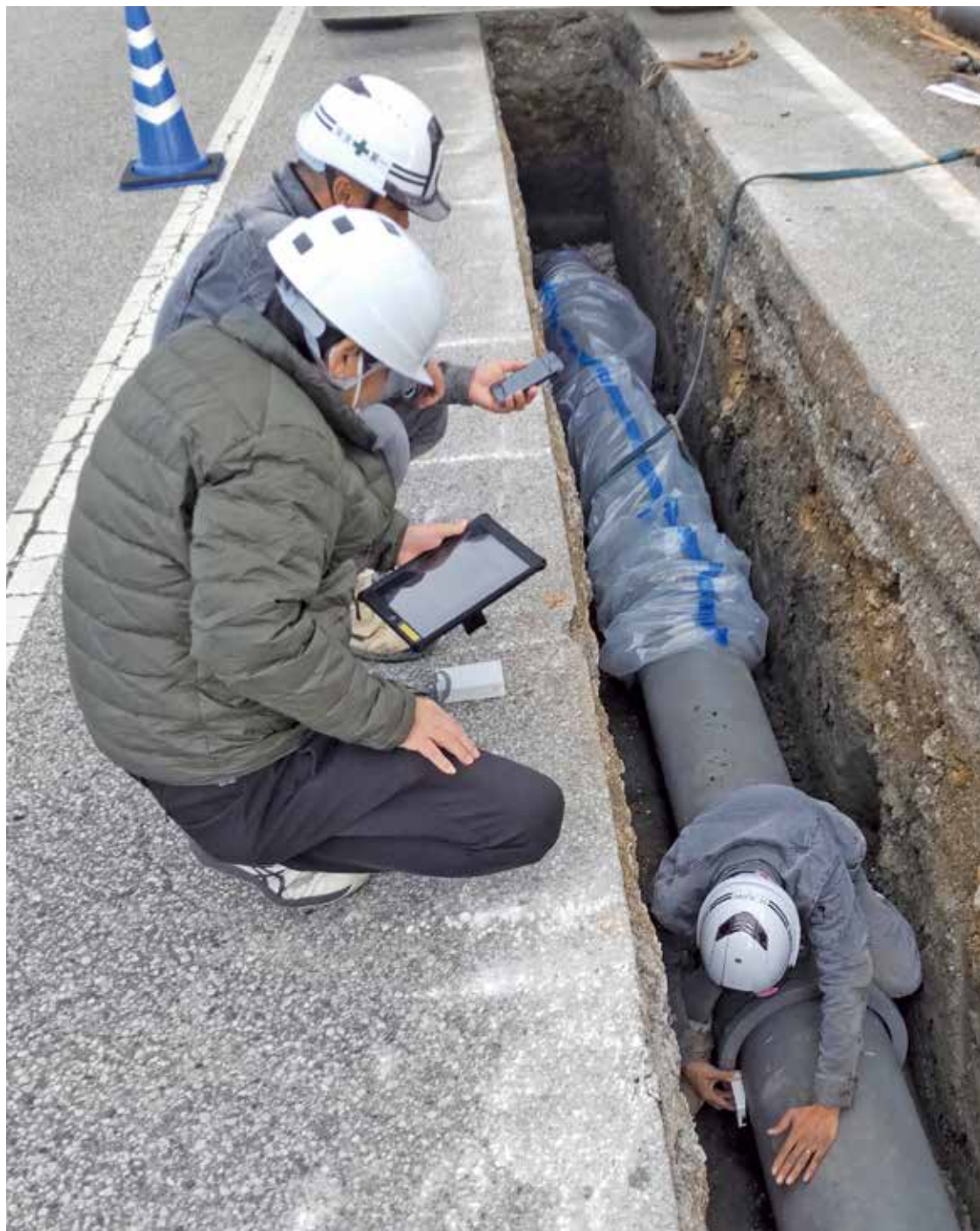
長浜水道企業団（滋賀県） GX 形 呼び径 350
