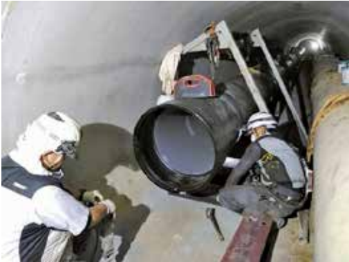
写真12 管受台への設置状況
