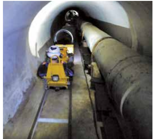
写真8 管運搬状況
